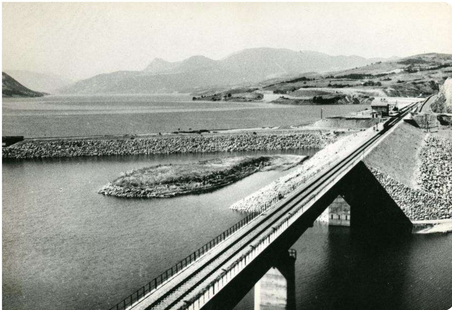
Puente ferroviario. Francia. Núm. registro 03-001692.
